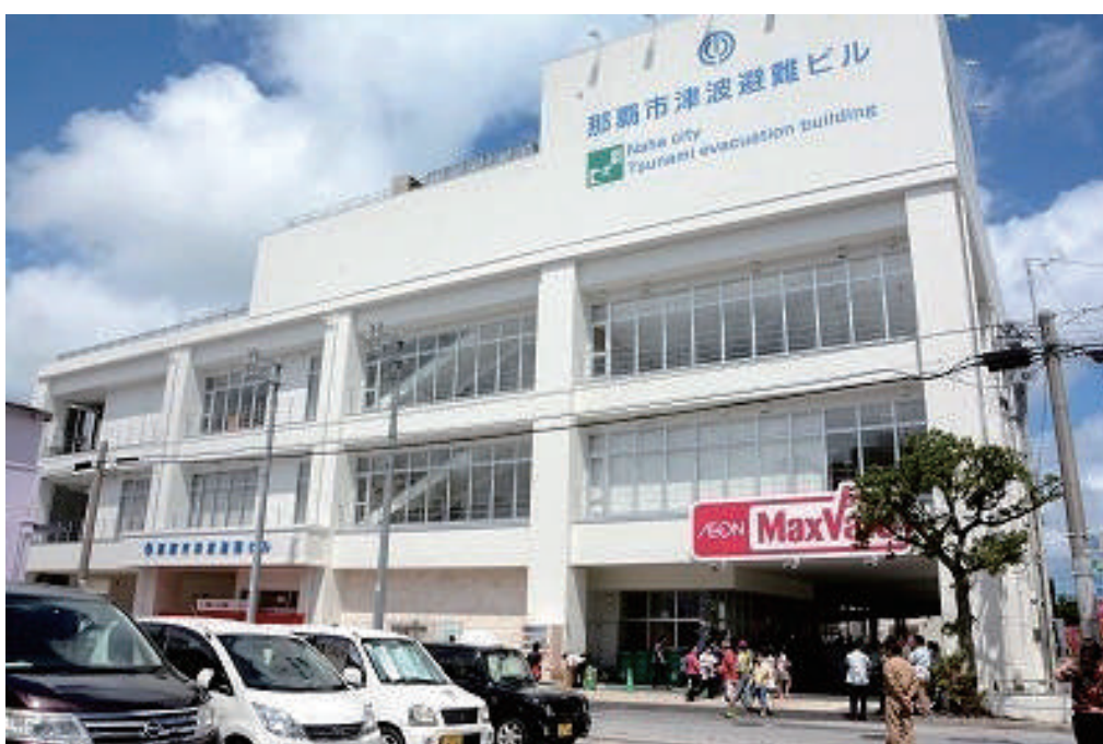
那霸市海嘯避難樓（那霸市松山 2-22-1）
